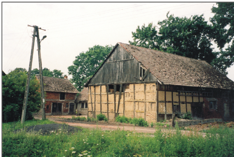
B. Nosalin - stodoła o konstrukcji szkieletowej
