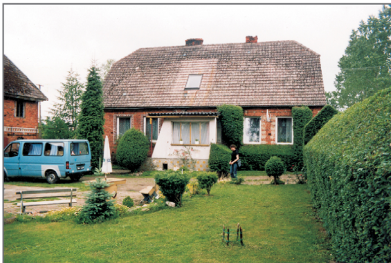
A. Nosalin - budynek mieszkalny o przekształconej bryle i zmienionej stolarce
